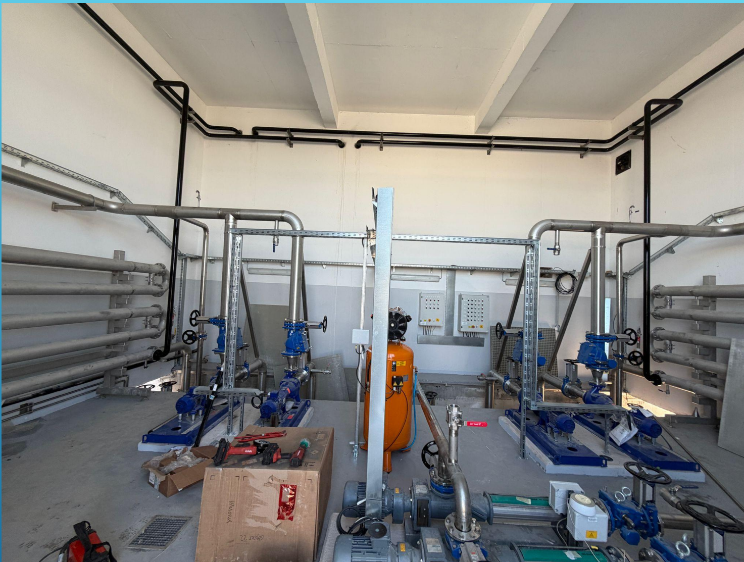
Strojarnica digestora – Objekt 22
